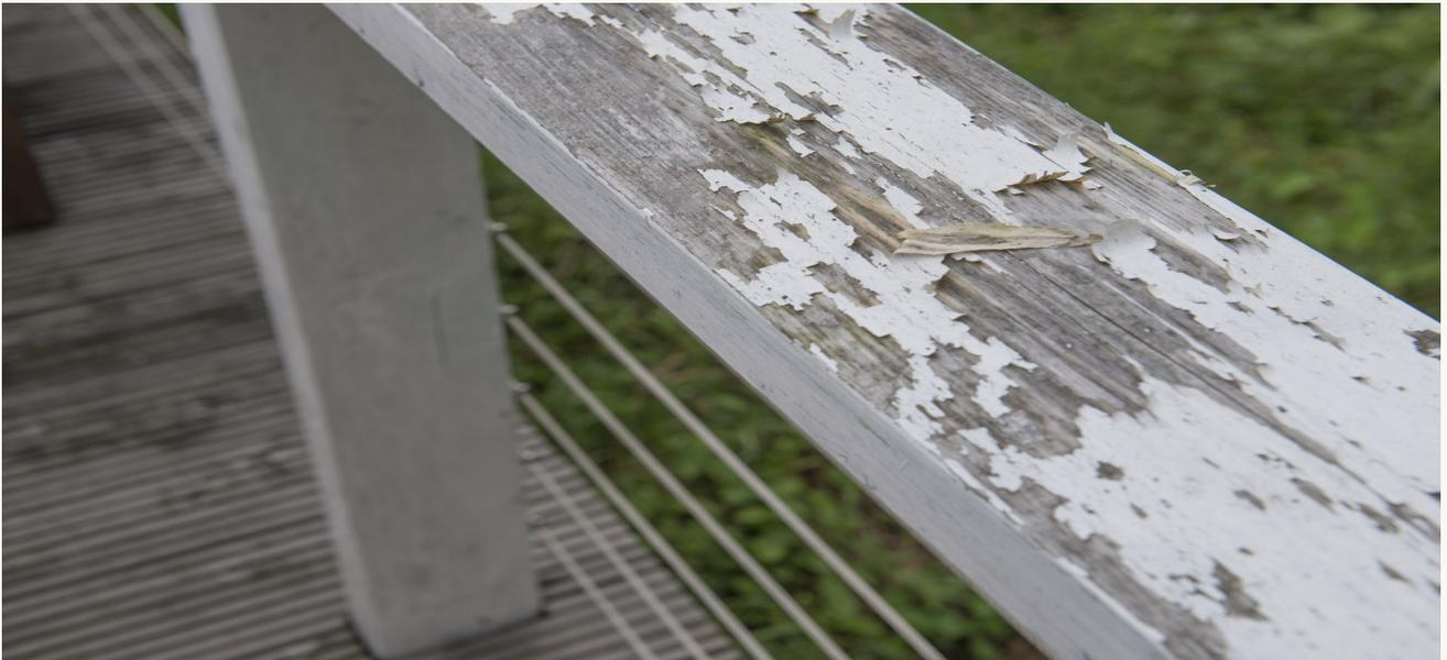
Die Farbe auf diesem Geländer blättert schon ab. Feuchtigkeit kann ungehindert in das Holz eindringen, bis es verwittert und morsch wird. Das UV-Licht der Sonne beschleunigt zusätzlich den Zersetzungsprozess. Höchste Zeit, den Oberflächenschutz zu erneuern.
