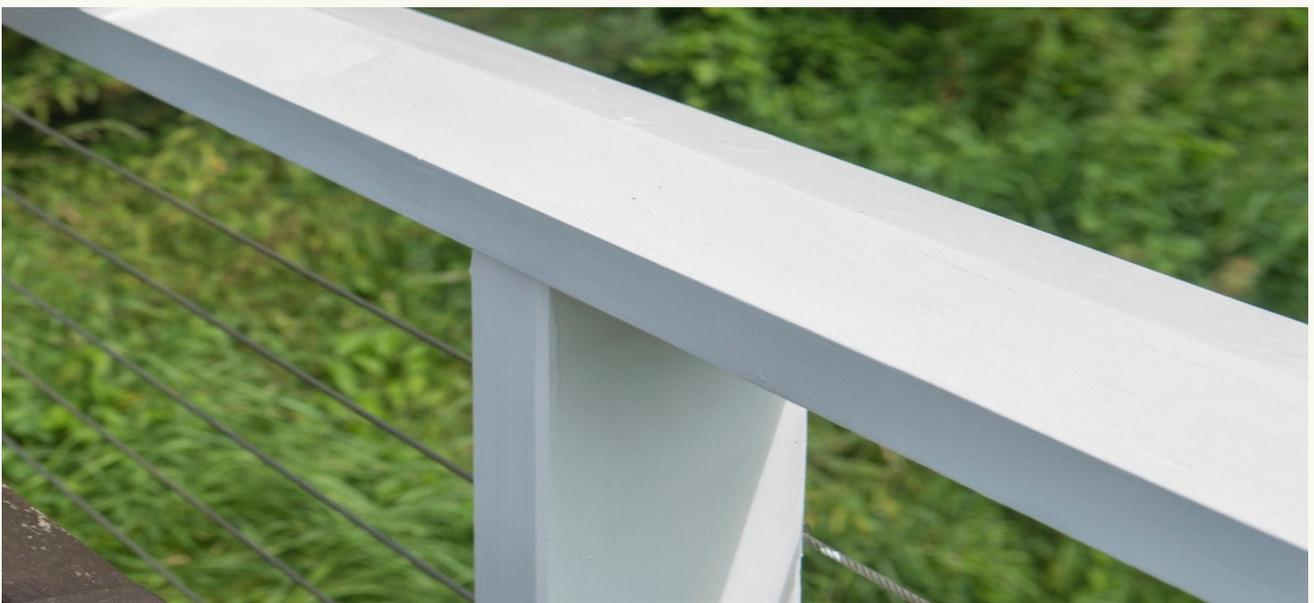
**Schritt 3:** Streiche die **Holzschutz-Grundierung** [1] unverdünnt mit einem weichen Pinsel in Maserrichtung. Das geprüfte Holzschutzmittel beugt Holzverfärbungen und Fäulnis vor. Achte beim Streichen generell auf gute Belüftung!
