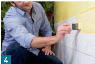
4 Mit einem Pinsel 2 x Consolan Wetterschutz-Farbe auftragen: Die deckende, wetterfeste Farbe auf Wasserbasis ist ideal für die farbige Gestaltung von Holz im Außenbereich. Trocknungszeit: jeweils ca. 2 Stunden.
