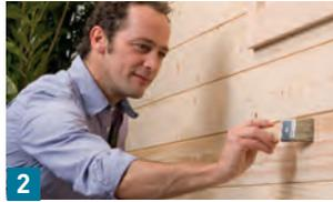
2 Die abgeschliffene oder neue Holzoberfläche wird mit Xylamon Imprägniergrund BP grundiert: Das Produkt erhöht die Haftung des Folgeanstrichs und sorgt für ein gleichmäßiges Anstrichbild.
