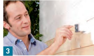
3 Bei hellen Folgeanstrichen sollten zwei Anstriche (3 Stunden Trockenzeit zwischen den Anstrichen) mit Isoliergrund Weiss aufgetragen werden. Dies ist eine deckende Spezialgrundierung, die das Durchschlagen von Holzinhaltstoffen und die dadurch entstehenden Verfärbungen verhindert. Dann 24 Stunden nach dem letzten Anstrich mit Consolan Wetterschutz-Farbe streichen.
