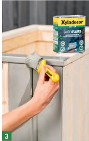
Xyladecor GardenFlairs 2x unverdünnt mit einem Flachpinsel satt und gleichmäßig auftragen (vor dem Folgeanstrich ca. 4 bis 5 Stunden trocknen lassen).
